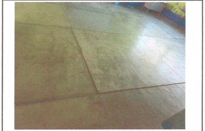
Foto 4: REMOZAMIENTO DE PISOS DAÑADOS
